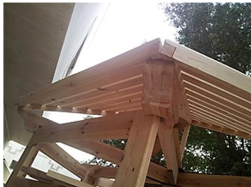
(شكل 34) يوضح تثبيت وحدات المقاعد والسقف
