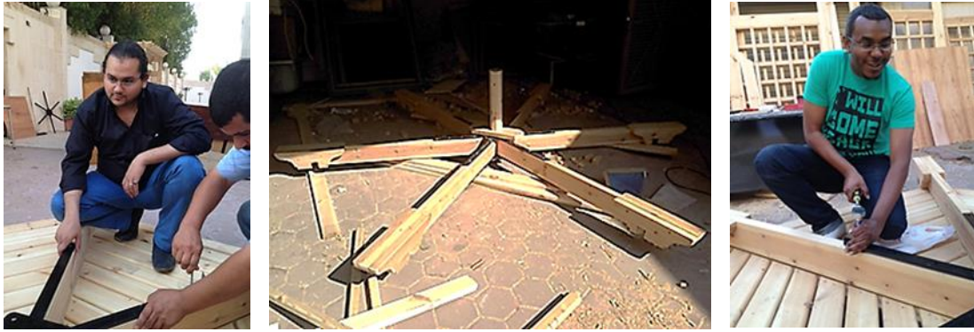
(شكل 26) يوضح مرحلة تثبيت النجمة المعدنية بين الفنى والطلاب ويوضح أيضاً بعد الإنتهاء من التثبيت أعلى وأسفل عوارض السقف
