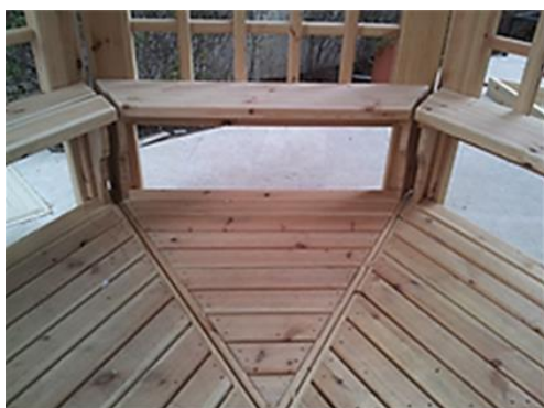
(شكل 34) يوضح تثبيت وحدات المقاعد والسقف
