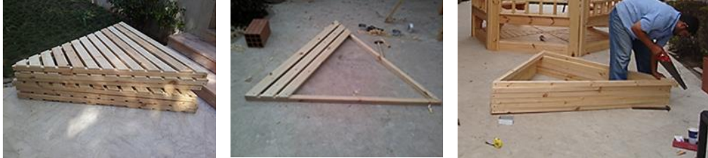
(شكل 30) يوضح تجهيز وحدات السقف وهي مثلثة الشكل وتتباعد ألواح الخشب بين بعضها لمرور الهواء بين السقف والجناح
