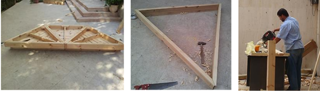
(شكل 23) يوضح الفنى ومنطقة العمل بالكلية وتجميع "القاعدة" أرضية المظلة السداسية وهي عبارة عن ستة أجزاء وقد تم تجميعها إلى جزئين يتم تثبيتهما ببعض بواسطة مسامير مجلفنة وقابلة لل فك والتركيب
