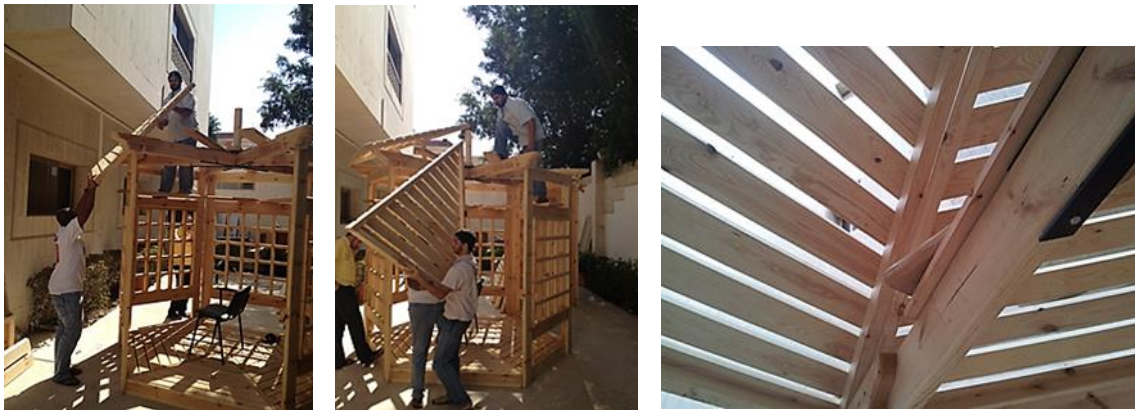
(شكل 31) رفع وحدات السقف لوضعها مكانها أعلى العوارض وكما هو موضح الفراغات بين ألواح الخشب لسهولة التهوية ومرور الهواء وضوء الشمس دون التأثير على الجالسين بداخلها
