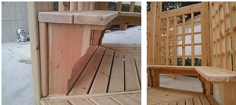
(شكل 33) يوضح المقاعد بعد التثبيت في أماكنها
