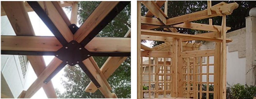
(شكل 27) يوضح الإنتهاء من جميع عوارض السقف ورفعها بشكل نهائى أعلى جوانب المظلة
