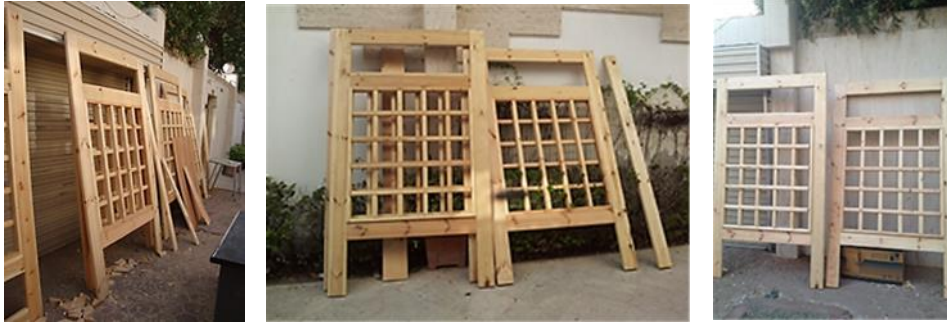
(شكل 24) يوضح أجناب المظلات بعد تجميعها
