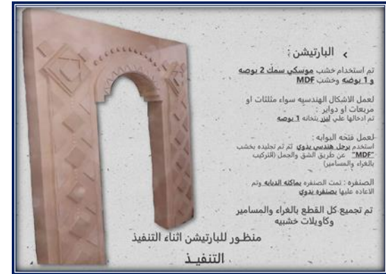
(شكل ٥٦) مراحل تنفيذ البارتيشن المستخدم في الكوان الخاص بمنطقة الإستقبال بالفندق خمس نجوم بأسوان.
