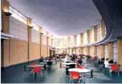
صورة رقم (١) توضح استخدام الأرفف الضوئية LIGHT SHELVES الداخلية والخارجية والتي تعكس ضوء الشمس مع توزيعه بصورة جيدة داخل الفراغ
