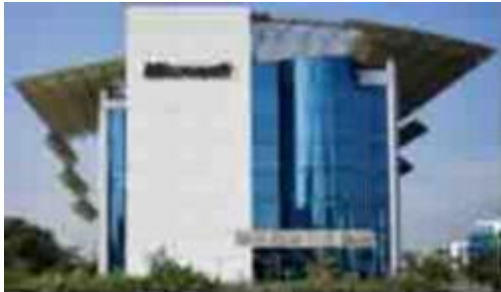
توضح أسلوب التظليل الخارجي لمبنى (صورة رقم ١) في القرية الذكية في مصر MICROSOFT
