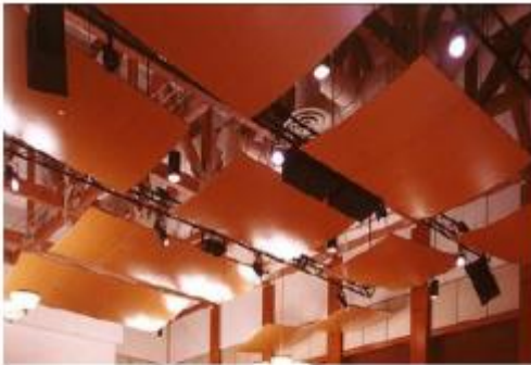
صورة رقم (١) توضح معالجة للأسقف تسمى Reflector Panels تعمل على تشتيت الموجات الصوتية لتوزيعها بالنظام في اتجاهات مختلفة
