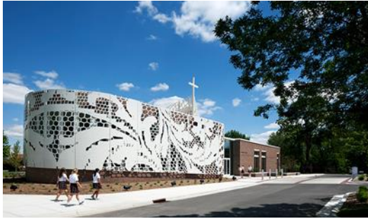
( صورة ١٩ ) تصميم وملابس زخرفية عضوية لواجهة أحد الكنائس بمدينة كانساس الأمريكية ، والتي تم تنفيذها عام ٢٠١٢ م باستخدام بانوهات الألومنيوم والتي أضفت إحساس بالجمال [35].
