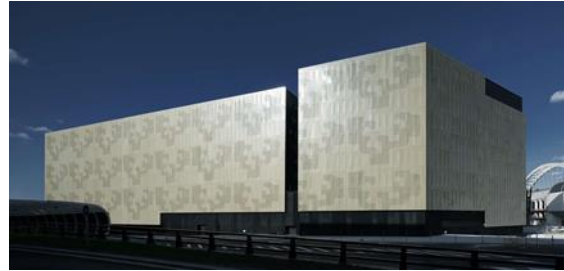
( صورة ١٨ ) واجهة مبنى - EUITI University School Mines بأسبانيا تم تصميمه باستخدام ألواح الصلب المثقوب ، وبالتالي يكتسب صفة الشفافية لتحقيق التهوية والإضاءة للفراغات الداخلية أثناء النهار بهدف التقليل من استخدام الطاقة [34].
