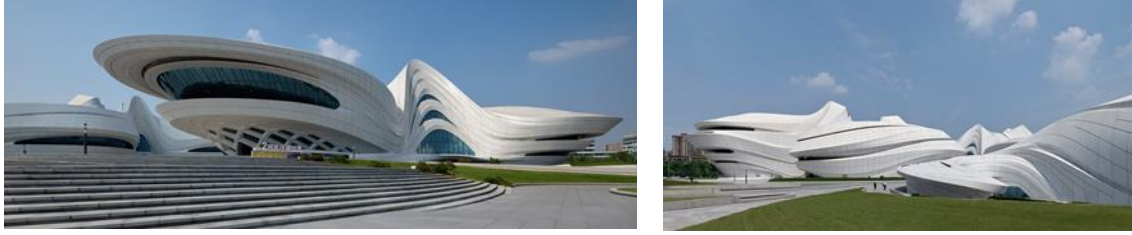
(شكل15) يوضح مبنى Changsha meixihu international من الخارج وإسلوب إستمرارية باستخدام خامة GRC
