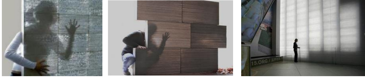
(شكل7) يوضح بعض من استخدامات خامة الأسمنت الشفاف كخوائك خارجية وفواصل داخلية
