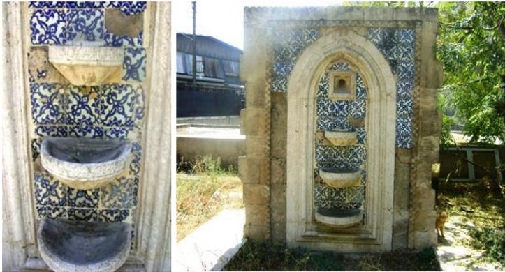
صورة رقم (٢٦) السلسبيل عبارة عن لوح رخامي متموج مستوحى من حركة الرياح أو الماء يوضع داخل كوة أو فتحة من الجدار المقابل للإيوان أو موضع الجلوس للسماح للماء أن يتقطر فوق سطحه لتسهيل عملية التبخر وزيادة رطوبة الهواء هناك، المصدر (٤٥).
