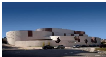
FIGURE 44. LA CORREDORIA HEALTH CENTER / DÍAZ|ROJO ARQUITECTOS
