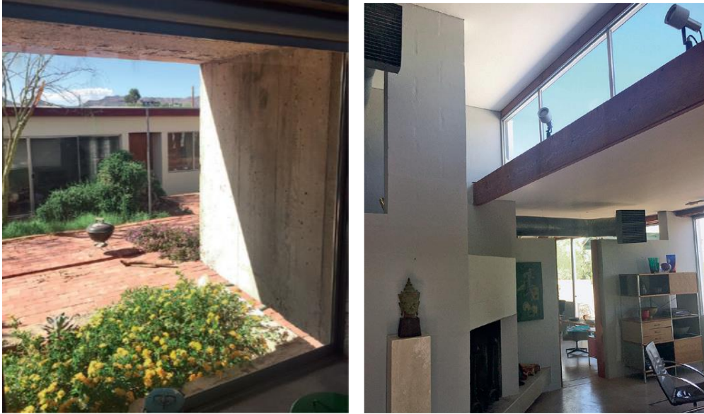
صورة 27 صورة 28 قامت المصممة المعمارية جوديث تشافي بتصميم نوافذ فاصلة مع أرفف خفيفة لتقليل الوهج وتوزيع ضوء النهار لوالدتها، كريستينا أفيلد جونسون، في توكسون أريزونا. (Altat Engineer 2018)
