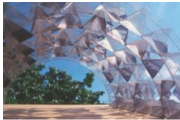
شكل (٢٧) استخدام الألواح الزجاجية كعنصر حامل مع نظام الكابلات
