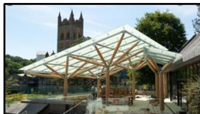
شكل (٢٢) هيكل إنشائي لمظلة بالنظام الكابولي
