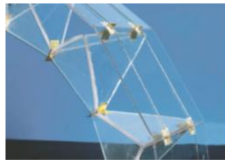
شكل (٢٧) استخدام الألواح الزجاجية كعنصر حامل مع نظام الكابلات
