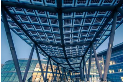
كما بالشكل (١٠) دمج الخلايا الشمسية وزجاج التحكم الشمسي في تغطية الأسقف والمظلات
