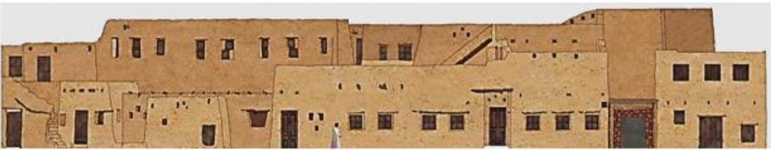
واجهة فندق الباننشال بعد الترميم والإرتقاء
