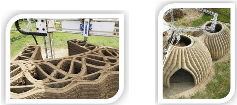
صورة (١٦،١٥) توضح تنفيذ النموذج المبدئي لمشروع تي كلا (TECLA) والذي ينفذ في إيطاليا ويقوم على فكرة صناعة موطن للحياة المستدامة وتوضح الصور طريقة الطباعة للمباني الضخمة ومدى تعقيد التصميم المصدر: www.3dwasp.com
