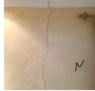
صورة (٥) - تشقق /صدع في الحائط الاسمنتي
