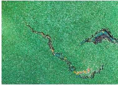
صورة (٩) - تفتت/تشقق في جزء من أرضية من المطاط
