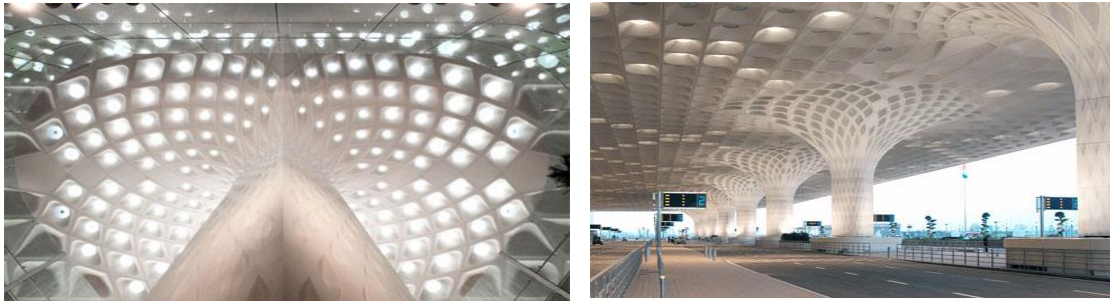
شكل (11) يوضح سقف مطار Mumbai's Chatrapati Shivaji International Airport الدولي حيث تم تصميمه بالأسلوب الخوارزمي حيث التسلسل والتكرار مع تغيير المقاسات، مع وجود فتحات من الزجاج للحصول على الضوء الطبيعي
