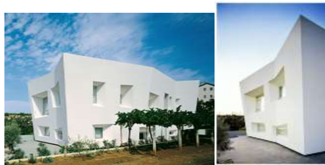
(صورة 13 أ ، ب ) ( Commercial Building ) كرواتيا - 2006 م ، استخدمت تقنية نانو التنظيف الذاتي ( تأثير زهرة اللوتس ) في الطلاءات الداخلية والخارجية للمبنى ، وتم تشبيه المبنى بقطعة الكريستال لبقاء اللون الأبيض ناصعاً لمدة خمس سنوات .
