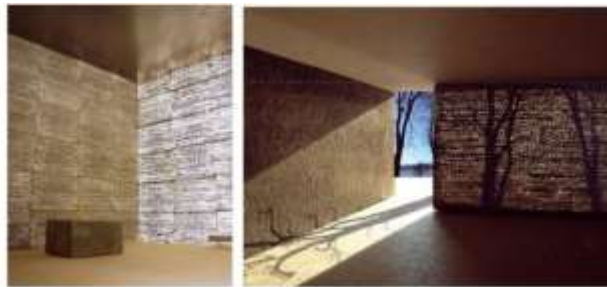
( صورة 4 أ ، ب ) توضح الخرسانه الشفافة وإمكانياتها العالية فى انعكاس البيئة المحيطة إلى داخل المكان . http://stroyfora.ru/p/post-316
