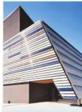
( صورة 17 ) مشروع (KKC) ، ألمانيا 2005م ، هذا المبنى يخص احدى الشركات العالمية لتصميم وتنفيذ الوحدات الصحية ، وقد تم تصميم الواجهة بوحدات سيراميك ملونة تم معالجتها بالطلاءات المعالجة بتكنولوجيا النانو (ETC) لزيادة كفاءتها وقدراتها على مقاومة الملوثات والعوامل الجوية المختلفة .
