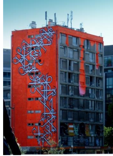
حائط بأحد المباني بفرنسا
