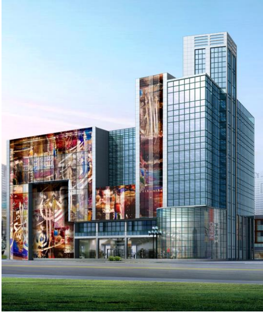
شكل (8) استخدام تقنية الطباعة الرقمية على الزجاج في عمل تصميم لواجهة زجاجية
