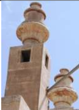
لوحة (8) نموذج لبعض مداخن القصر.
