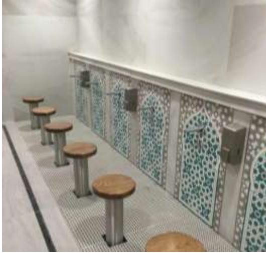
شكل " 16 " نموذج (1) لوحدة الوضوء ذو المقعد
