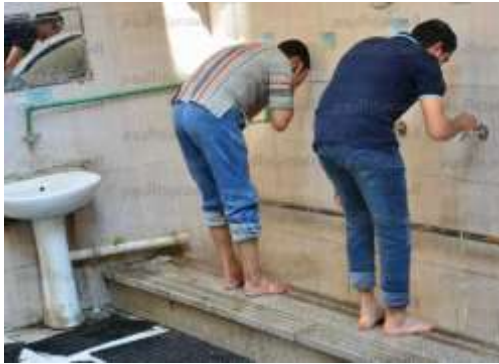
شكل "11" خلل أبعاد وحدات الوضوء وعدم ملاءمتها للاستخدام خاصة لكبار السن ومستخدمي المقاعد المتحركة
