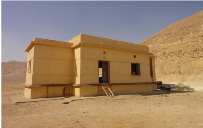
لوحة(1)الواجهة الجنوبية الغربية لمبنى الاستراحة الرئيسي (تصوير الباحث)
