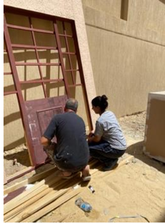
شكل (٢١) اثناء تنفيذ الشاسيهات
