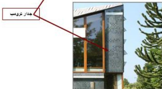
(شكل ٢٥) عزل جدار ترومب Insulation The Trombe Wall (\*)
