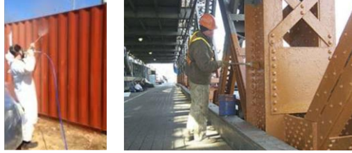
صورة 1 راتنج الإيبوكسي يستخدم في تكسيبات وطلاءات المنتجات الصناعية بهدف صيانتها
