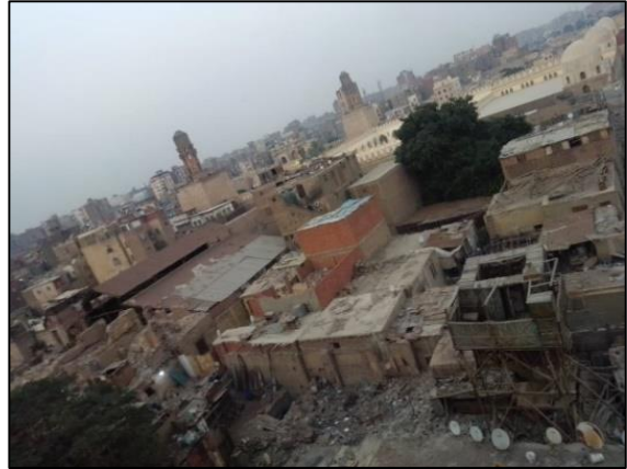
شكل رقم (٥): الوضع الراهن المنطقة الجنوبية لمسجد الحاكم حتى شارع الضبابية
