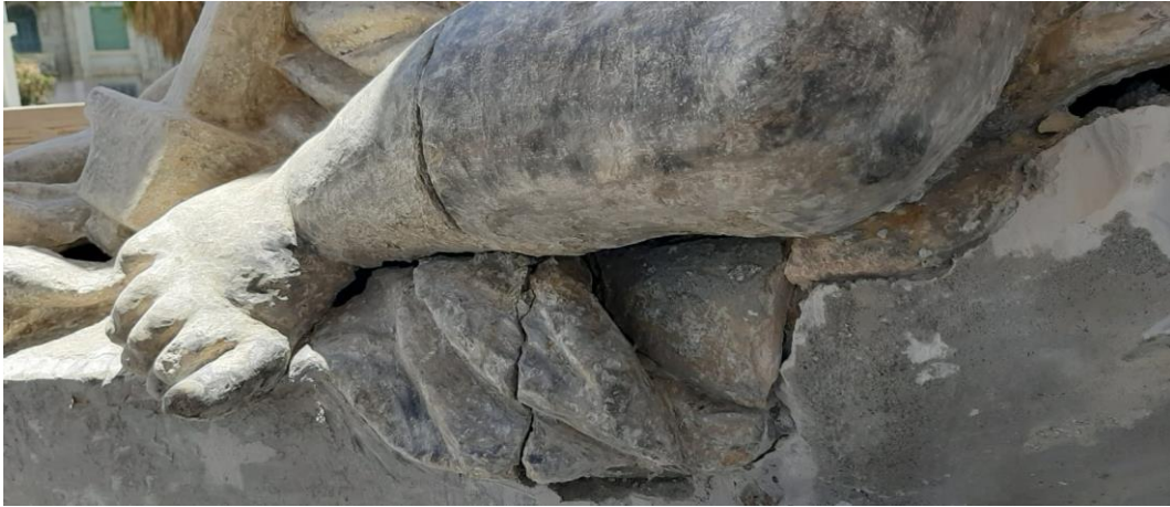
شكل رقم (١٢): احد مظاهر التلف الناتج عن عمليات الترميم الخاطئه ( اضافة جبس مع الحجرالصناعي )
