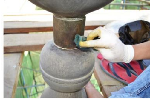
شكل (١٩) يوضح استعواض الزخارف الحجرية المفقودة في شرفات المأذنة بأخرى جديدة مثيلة للقديمة وتثبيتها بنفس الأسلوب القديم
