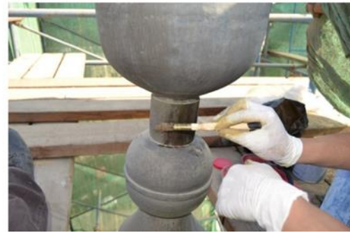
شكل (٢٢) ترميم الهلال النحاسي التنظيف الميكانيكي التنظيف الكيميائي NaOH 50 gms KNaC4H4O6·4H2O 150 gms H2O2 10% التقوية والعزل 3% Benzotriazole
