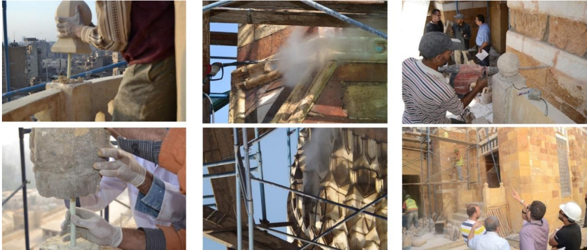
شكل (١٨) استكمال البابوات المفقودة بعمل بابوات جديدة مثيلة للقديمة وتثبيتها بعيان الفايبير الزجاجي (fiber glass) وتثبيتته باستخدام ايوكسي
