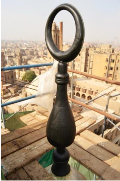
شكل (٢٣) يوضح الهلال النحاسي بعد الترميم
