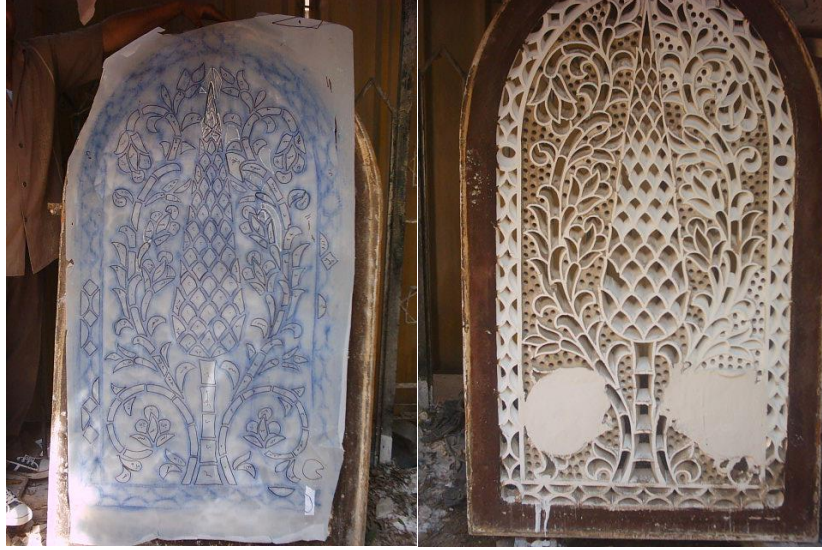
شكل ( ١٢ ) يوضح الشباك معشق من الجص مستوحى من شجرة السرو قبل واثناء الترميم
