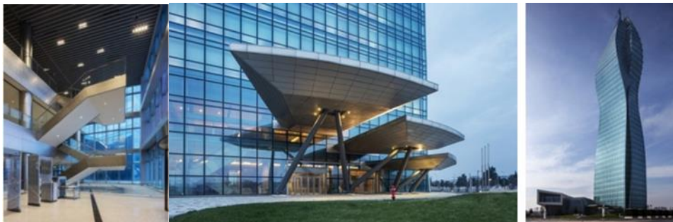
شكل ( ١٢ ) يوضح استخدام تقنية الزجاج الفعّال في واجهات المبنى الإدارى لشركة Socar tower
