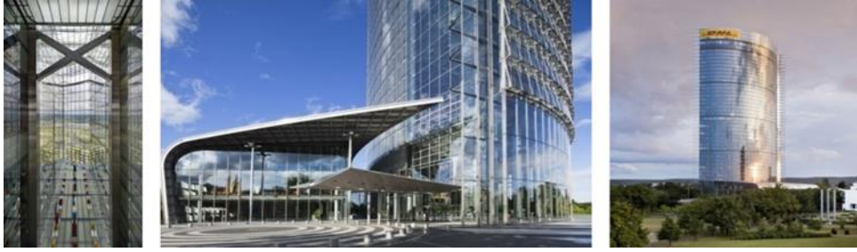
شكل (١٣) استخدام الزجاج المقاوم للحريق بسقف المبنى الإداري لشركة Deutsche post ألمانيا - ٢٠٠٥
