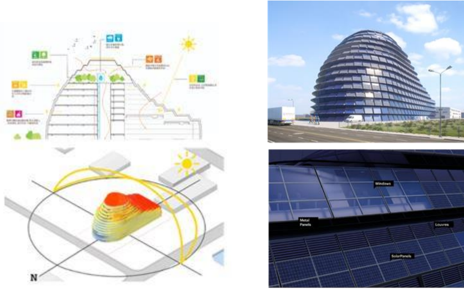
شكل ( ٧ ) إستخدام الخلايا الشمسية فى توليد الطاقة لتطوير كفاءة الحيزات الداخلية تايوان - ٢٠٢١
