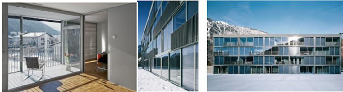
شكل (١٥) استخدام الزجاج الحراري في الواجهات بمبنى دار المسنين "Sur Falveng" housing سويسرا - ٢٠٠٥
