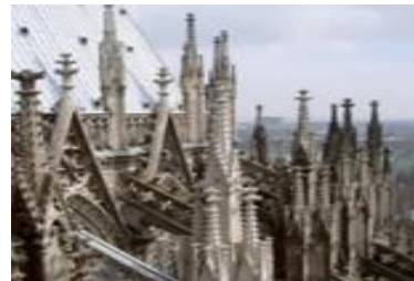
شكل (١٩) الدعامات الطائرة
