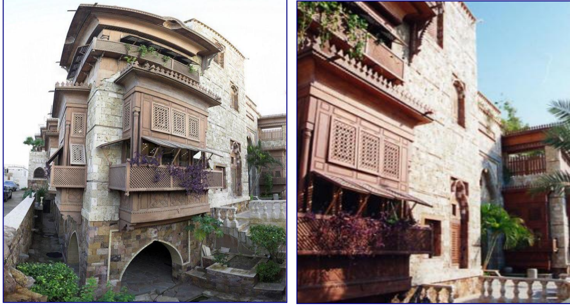
(شكل ٣٩) أشكال المشربيات والرواشين التي تم استخدامها في واجهة المنزل، تم مزج الهوية المعمارية مع المعالجات البينية باستخدام الخامات المحلية والرواشين والمشربيات
