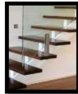
شكل (25) تثبيت الدرايزين الزجاجى أعلى السلم بقوائم معدنية
