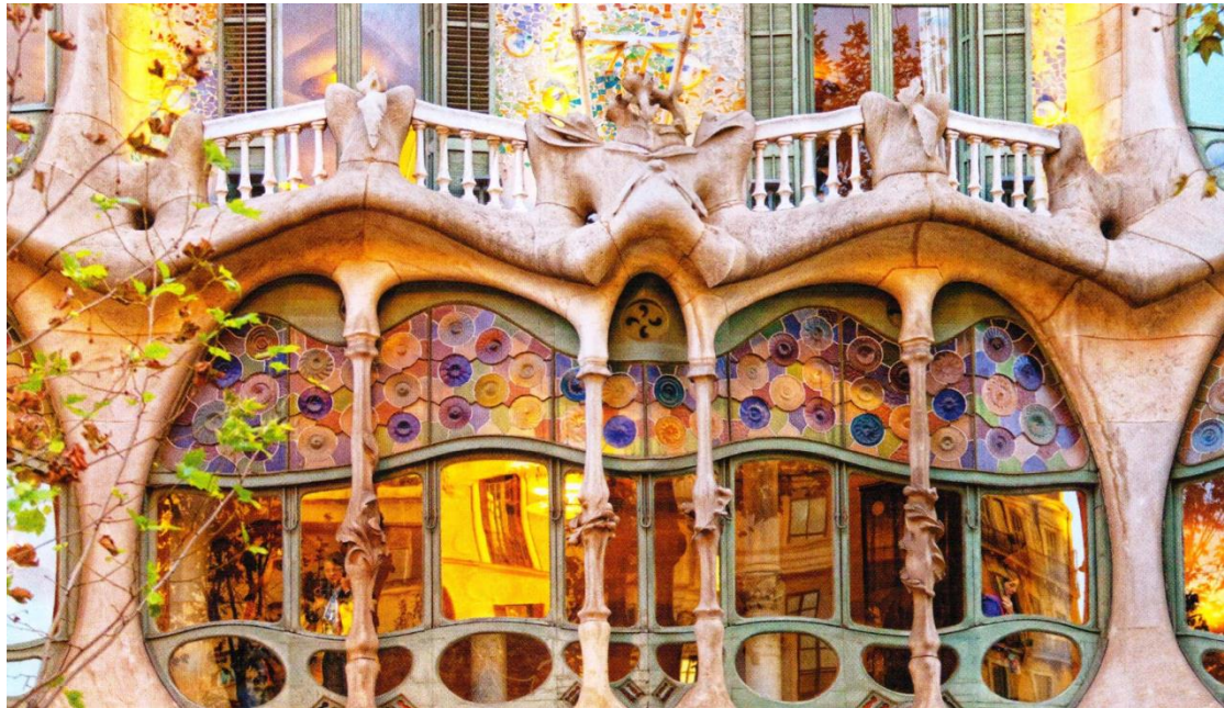
شكل رقم (١٦): مبنى كازا باتلو Casa Batllo انشأه انتوني جاودي Antoni Guadi اقيم في برشلونه، اسبانيا
