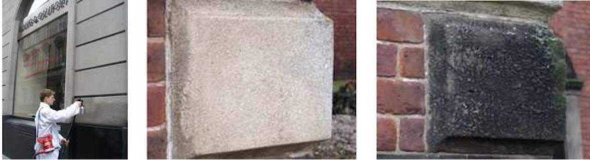
شكل رقم (١٣) يوضح أثر دهان النانو على الحجر بالواجهات (على اليمين الحجر بدون معالجة و على اليسار الحجر المعالج)
