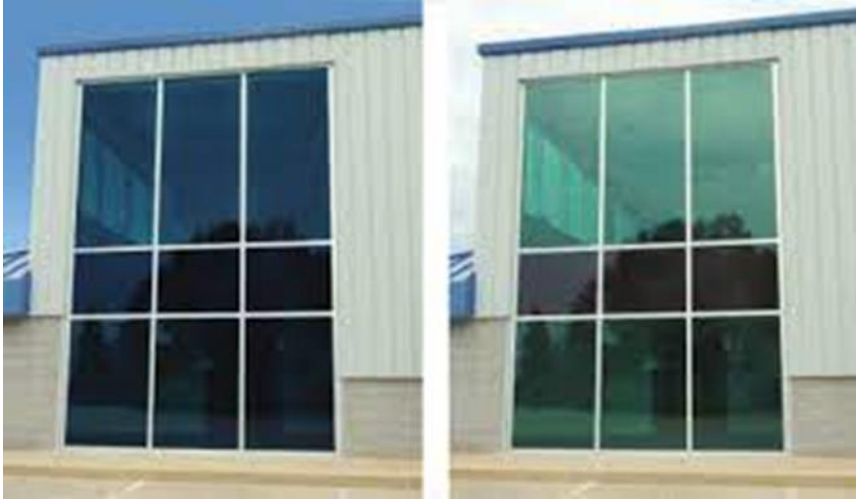
صورة رقم (١٣) توضح الزجاج المستخدم لتقنية photochromic technology
