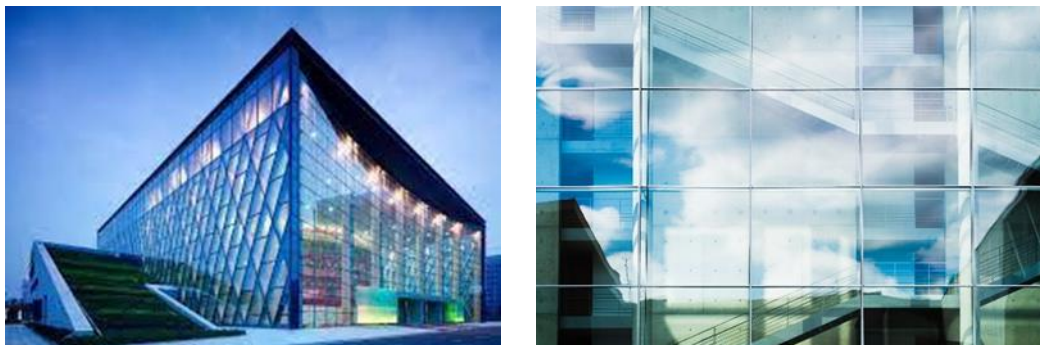
صورة رقم (٩) توضح استخدام الزجاج الهلامي في عملية الإنشاء
