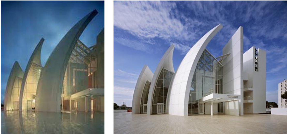
صورة رقم (٢) توضح استخدام مادة ثاني أكسيد التيتانيوم في عملية إنشاء كنيسة اليوبيل في إيطاليا للمعماري ريتشارد ماير
