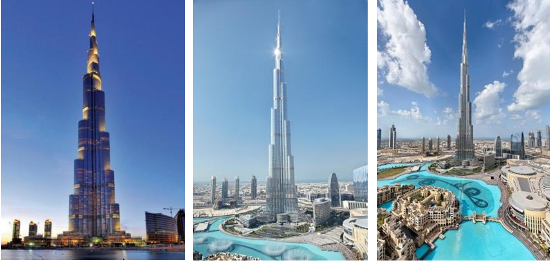
صورة رقم (١) توضح استخدام المواد النانوية (الميكرو سيليكيا والنانو سيليكيا) مع الخرسانة المستخدمة في عملية الإنشاء لبرج خليفة بدولة الإمارات المتحدة مما ساعد على زيادة ارتفاع البرج بشكل كبير
