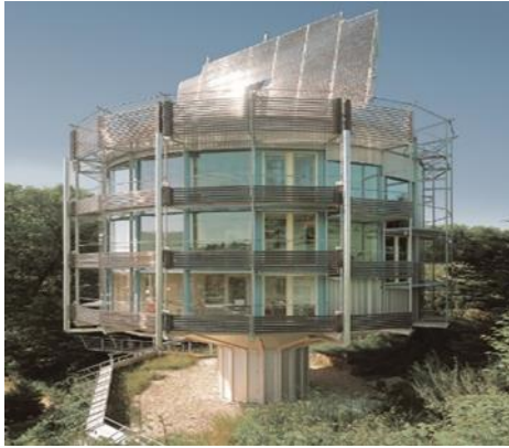
صورة رقم (١٦) توضح مسطحات الزجاج الخارجية التي تسمح بمرور أشعة الشمس إلى داخل المبنى
