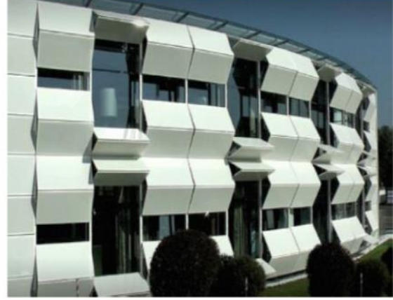
صورة رقم (١) توضح معرض كيفر التقنى بالنمسا، حيث تحتوي واجهة المبنى على هياكل من لوحات معدنية متحركة لتتكيف مع التغيرات المحيطة لتلبية راحة المستخدم في الفراغات الداخلية للمبنى
