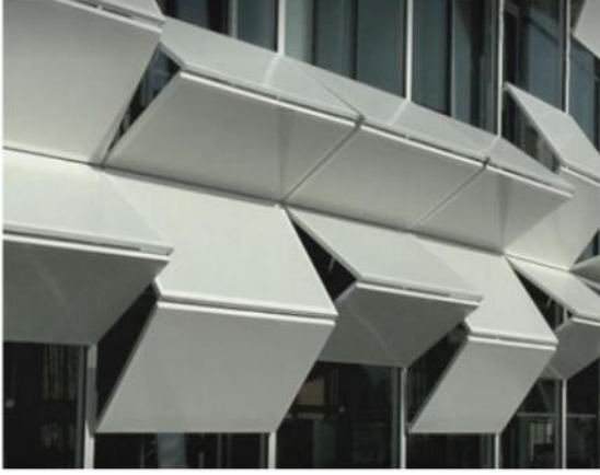
صورة رقم (١) توضح معرض كيفر التقنى بالنمسا، حيث تحتوي واجهة المبنى على هياكل من لوحات معدنية متحركة لتتكيف مع التغيرات المحيطة لتلبية راحة المستخدم في الفراغات الداخلية للمبنى
