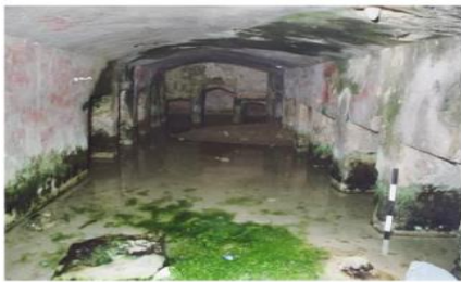
الشكل ٥ : تسرب المياه الجوفية داخل مقابر الشاطبي في الإسكندرية.
