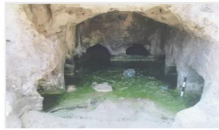
الشكل ٥ : تسرب المياه الجوفية داخل مقابر الشاطبي في الإسكندرية.
