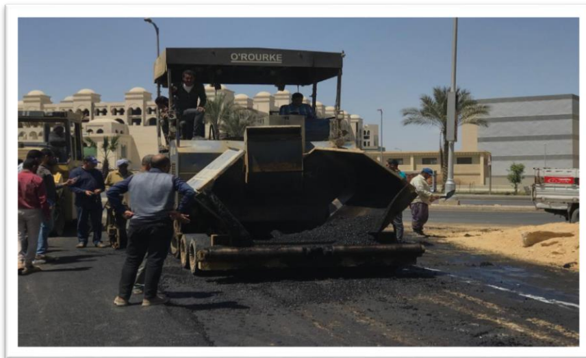
شكل رقم(16) سطح الطريق اثناء فرش الاسفلت الزجاجي
