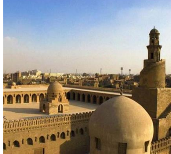
شكل (٨) يوضح الواجهة الخارجية لمسجد احمد بن طولان بالقاهرة
