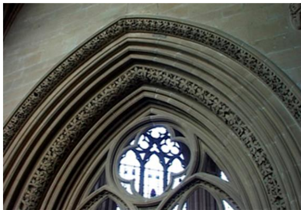
شكل (٦) يوضح رؤية القوس المدبب بشكل ثلاثي الابعاد (القوس المضلع) شكل (٧) يوضح القوس المدبب في العمارة القوطية
