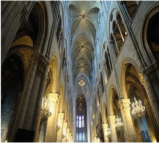
شكل (١١) يوضح المحراب الداخلي للكنيسة وفيه العقد المدبب ذوالمركزين
