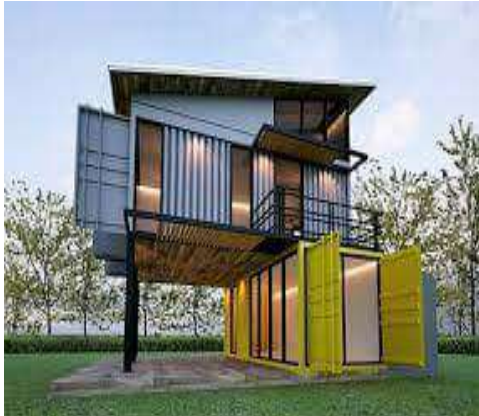
شكل رقم (3) يوضح العديد من افكار كيفية اعادة استخدام حاويات الشحن في عمل وحدات سكنية متعددة الاغراض
