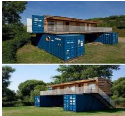
شكل رقم (5) اعادة استخدام حاوية الشحن في عمل منازل اقتصادية
