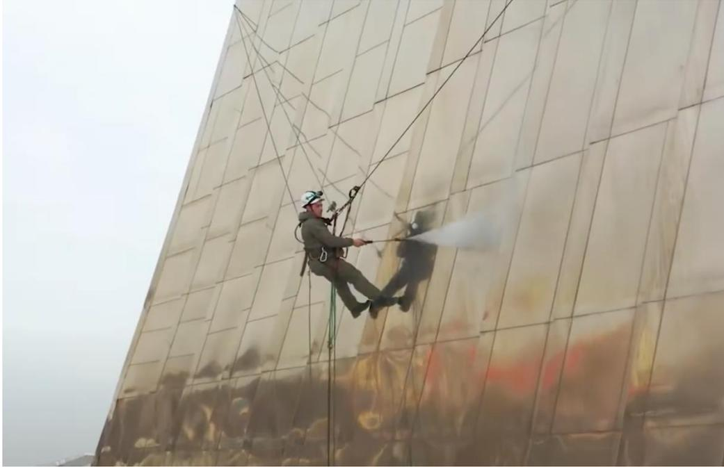
صورة رقم (١٣) توضح احدي العمال وهو يقوم بعمليات التنظيف للنصب التذكري لغزاة الفضاء باستخدام مضخة المياه ذات الضغط العالي
