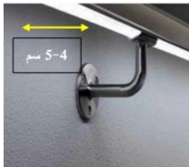
صورة رقم (9) توضح مسند للإتكاء مثبت علي الحائط و مضاءة من أسفل و يوضح مدى بُعد عن الحائط بقيمة ( 4 أو 5 سم). المصدر: (داليا، 2022)
