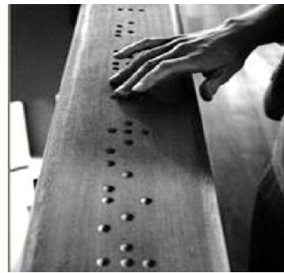
صورة رقم (12) توضح استخدام تقنية برايل بدرابزين السلم أو بحواجز الحماية مما يساعد محدودي البصر على مواصلة الحركة من خلال حاسة اللمس. المصدر: (Amira, 2022).
