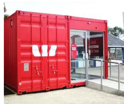
صورة رقم (8) توضح توفير منحدرات و أجهزة فتح الأبواب الآلية لتسهيل الوصول. المصدر :
