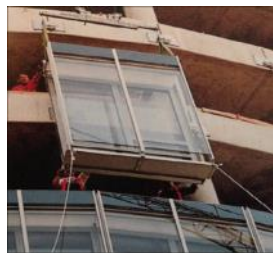
شكل 16: استخدام النوافذ المكعبة لفصل الفراغ الوسطي بين طبقات الغلاف المزدوج لتحسين منع الضوضاء الداخلية (13)
