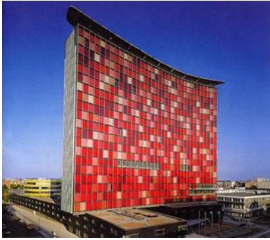
شكل 3 : واجهه مبنى GSW الذكية، تتميز بالقدرة على الاستجابة في الوقت المناسب، يجمع بين التحكم الآلي والتحكم من قبل السكان (5)
