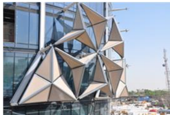
شكل 14: برج البحر - واجهة متحركة يظهر الكاسرات الشمسية المتحركة القابلة للدوران والضبط - العمل بالأنظمة الميكانيكية (11)
