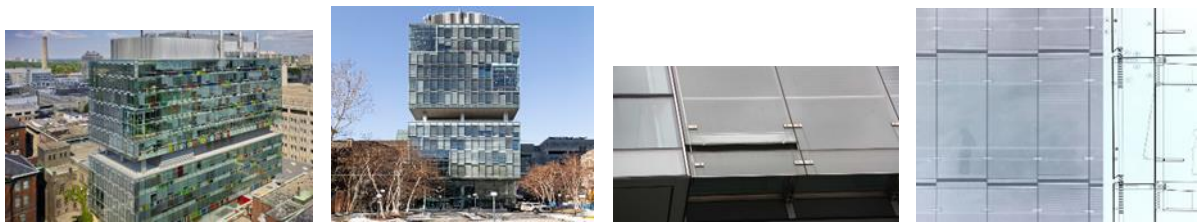
شكل 1 : الواجهه الذكية المزودة لمركز تيرينس دونيلي في جامعة تورنتو مع تظليل تلقائي متكامل(3)
