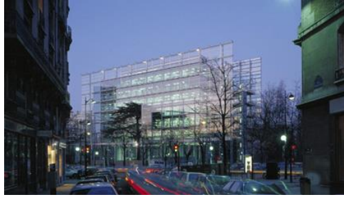
شكل 15: مبنى Cartier Foundation for Contemporary Art, Paris, France يوضح الحائط الزجاجي الصوتي العازل والعاكس للصوت لزيادة الخواص الصوتية للغلاف الخارجي (12)
