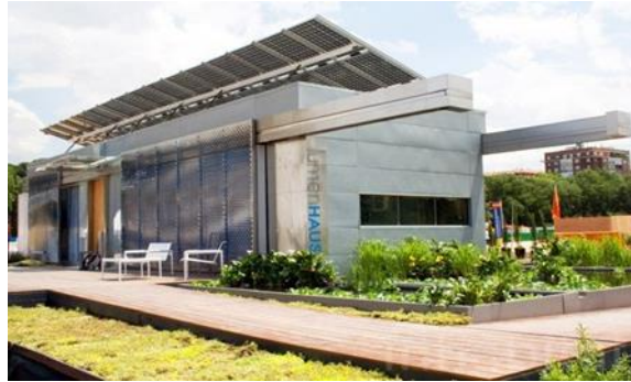
شكل 28: يوضح جدران التظليل الخارجية المتحركة لمنزل لومن هاوس (27)
