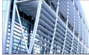
شكل 21: يوضح كاسرات الشمس الخارجية المتحركة التي تتبع مسار الشمس لمنع الوهج والأكسبات الحراري مع السماح بنفاذ الضوء
