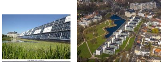
شكل 19: يوضح استخدام الأسطح الكهروضوئية في الأغلفة الخارجية لمبنى Rhine Elbe Science Building (14)
