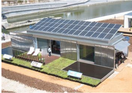
شكل 31: مصفوفة الخلايا الشمسية الموجودة على سطح منزل لومن هاوس (31)
