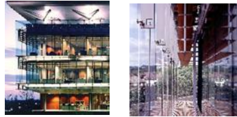
شكل 9: الفراغ الهوائي للواجهة ذات شرائح التهوية المزدوجة لمبنى Glaxo Wellcome House West (9)
