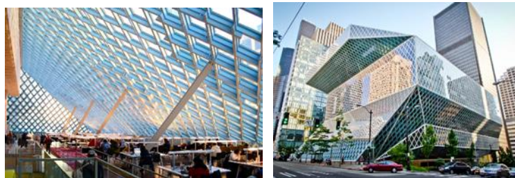
شكل 20: مبنى Seattle public library, Washington يوضح تكامل الخلايا الكهروضوئية مع الزجاج بحيث تسمح بالرؤية (15)
