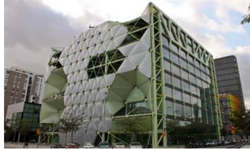
شكل 2: غلاف ذكي مكون من ظلال صفائحية مغلقة بمادة ETFE تعمل بالطاقة الشمسية تم تطويره لمبنى Media-TIC في برشلونة (4).
