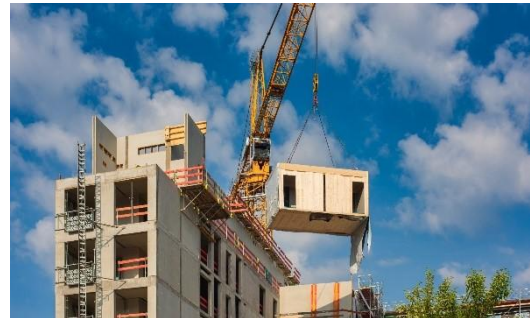
صوره رقم: 1 توضيح: طريقة التعليق المباشر
