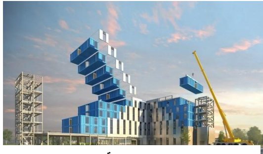
صوره رقم: 2 توضيح: طريقة نقل الوحدات المعيارية بجانب بعضها لتكوين المبني
