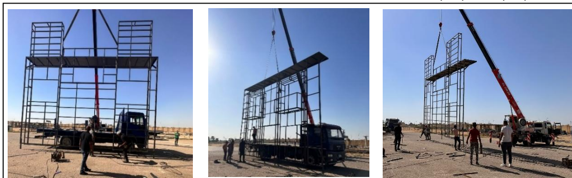
ش 38 تحميل الهيكل الحديدي علي العربات - تصوير الباحثة
