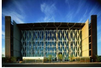
صورة (3): نظام تظليل شرائحي متحرك - صورة (4): النظام الشرائحي الثابت في الواجهة الشمالية
