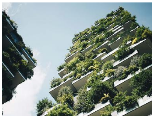
صورة (17) مبنى بوسكو فيريتيكال السكني https://www.arch2o.com/vertical-forest-bosco-verticale-stefano-boeri-architects
