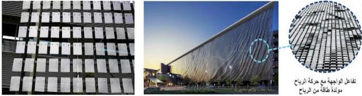
شكل (24) مثال يوضح دور الأنظمة الحركية في توليد الطاقة من الرياح
