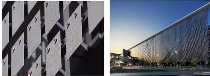
شكل (20) غلاف مبنى مواقف مطار Brisbane المستجيب لحركة الرياح
