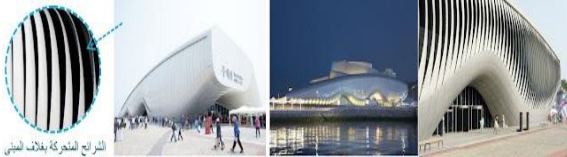
شكل (16) نظام الحركة المعتمدة على تشوه المادة ومرونتها في مبنى One Ocean بكوريا الشمالية
