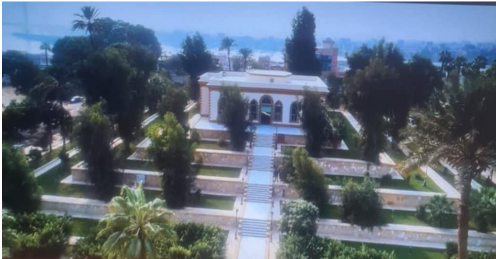
شكل رقم (2) متابعة جودة تنفيذ أعمال التطوير والترميم (بالدرون) فى الوقت الفعلى.
