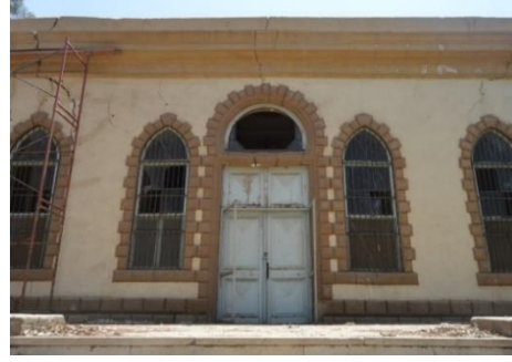
شكل رقم (6) مراقبة جودة التنفيذ لأعمال الترميم
