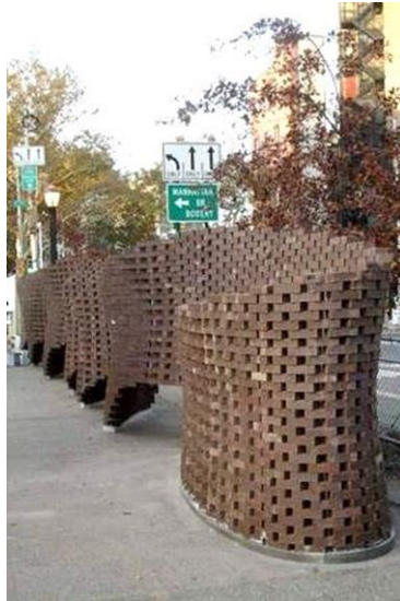
شكل رقم (12) يوضح صورة لجدار يتضح فيه طريقة تركيب بلاطات من الطوب الاحمر تعتمد على فن العمارة الانسيابية والتصميم الباراميتري
