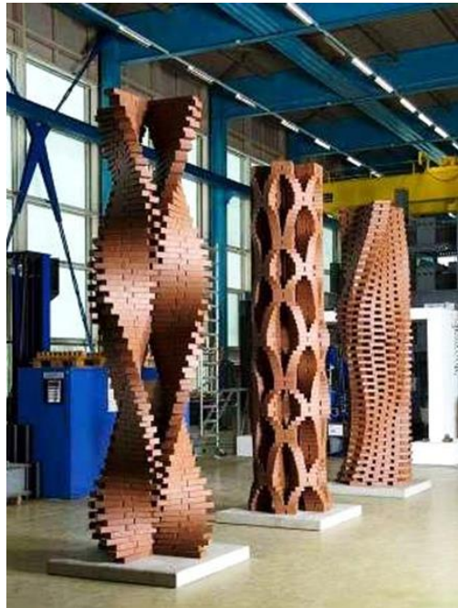
شكل رقم (11) يوضح صورة لعمود يتضح فيه طريقة تركيب بلاطات من الطوب الاحمر تعتمد على فن العمارة الانسيابية والتصميم الباراميتري
