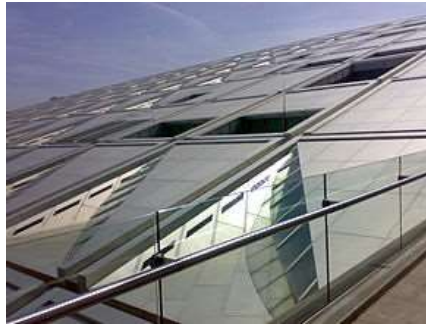
صورة (1-11) توضح تصميم السطح الخارجي لمكتبة الإسكندرية، حيث صُمم لدخول ضوء الشمس الطبيعي للفراغ الداخلى لتوفير تكاليف الإضاءة الصناعية.
