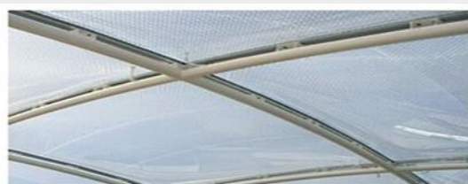
شكل رقم 2 يوضح طريقة تركيب وسادات ETFE فى الهياكل المعدنية الخاصة بها (مرجع 23)
