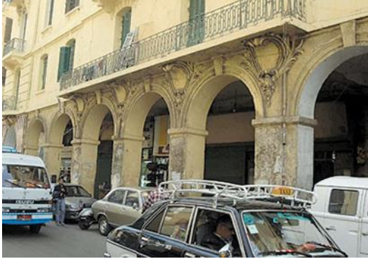
صورة (2): شارع كلوت بك- القاهرة.
